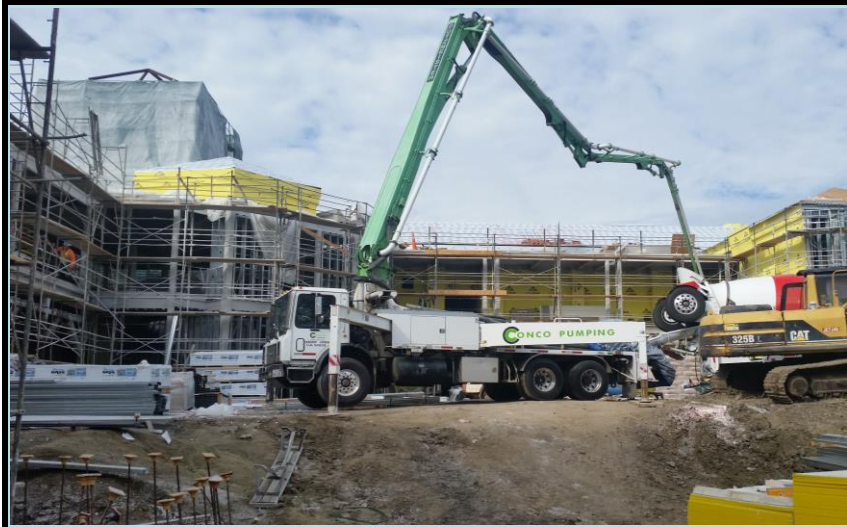
Concrete Deck Pour
